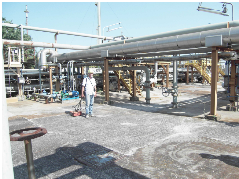
Rilievo di sottoservizi in una raffineria
