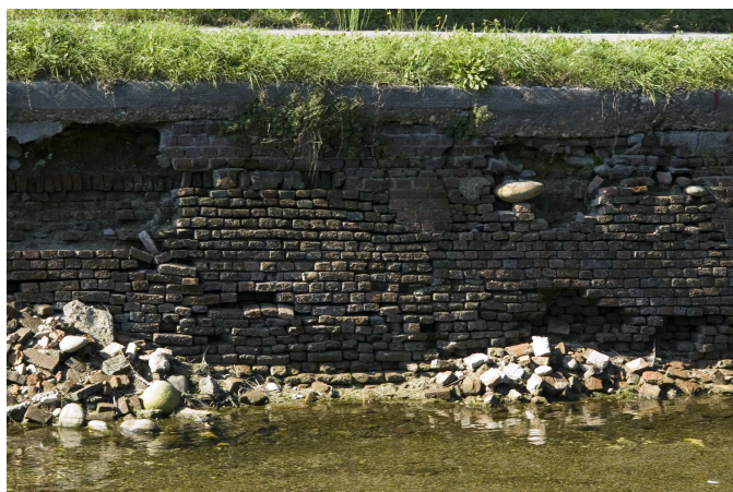
Sequenze di controllo dello stato di fatto di argini
