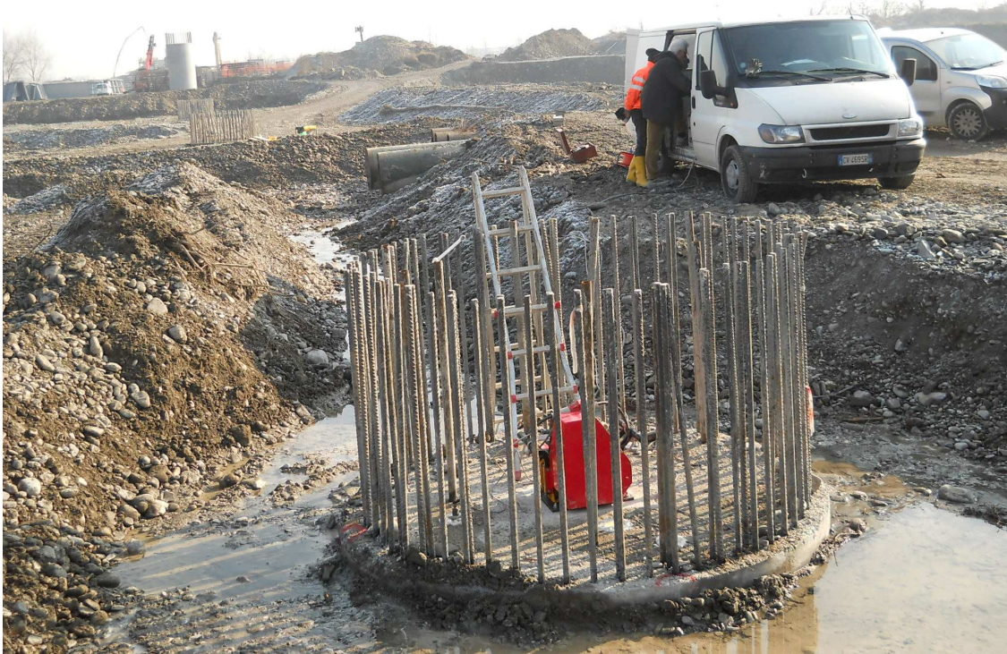
Vibrodina ad alta potenza 30KN – palo L= 32m d= 2800mm
