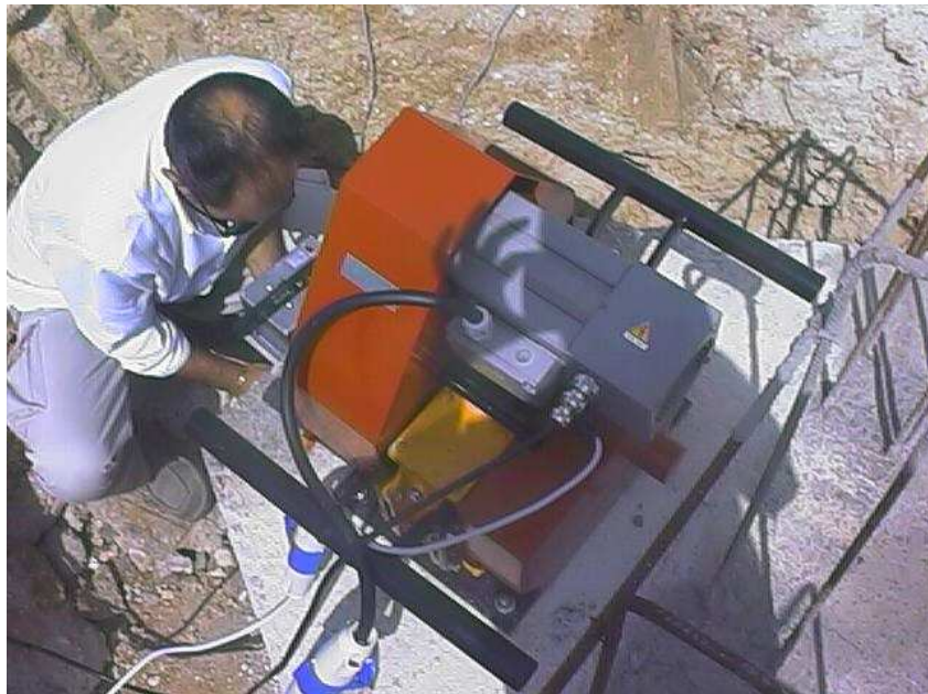
Foto n.3 - posizionamento della vibrodina
